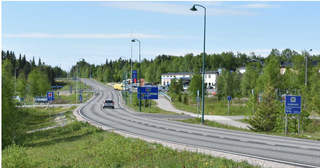
Kuva 25. Valtatie 21 ja kantatie 79 risteysalue pohjoisen suunnasta (FCG / Minna Takalo)
