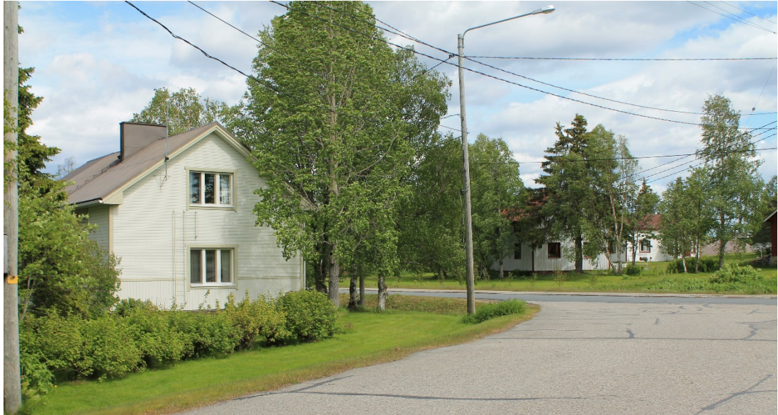
Kuva 14. Perinteistä rakennuskantaa Lahenrannantien varrelta (FCG / Mari Lampinen)
